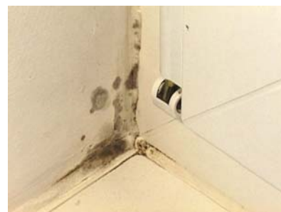
Plijesan u području materijalnoga toplinskoga mosta
